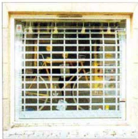
Gitre til tyverisikring opsættes indvendigt
