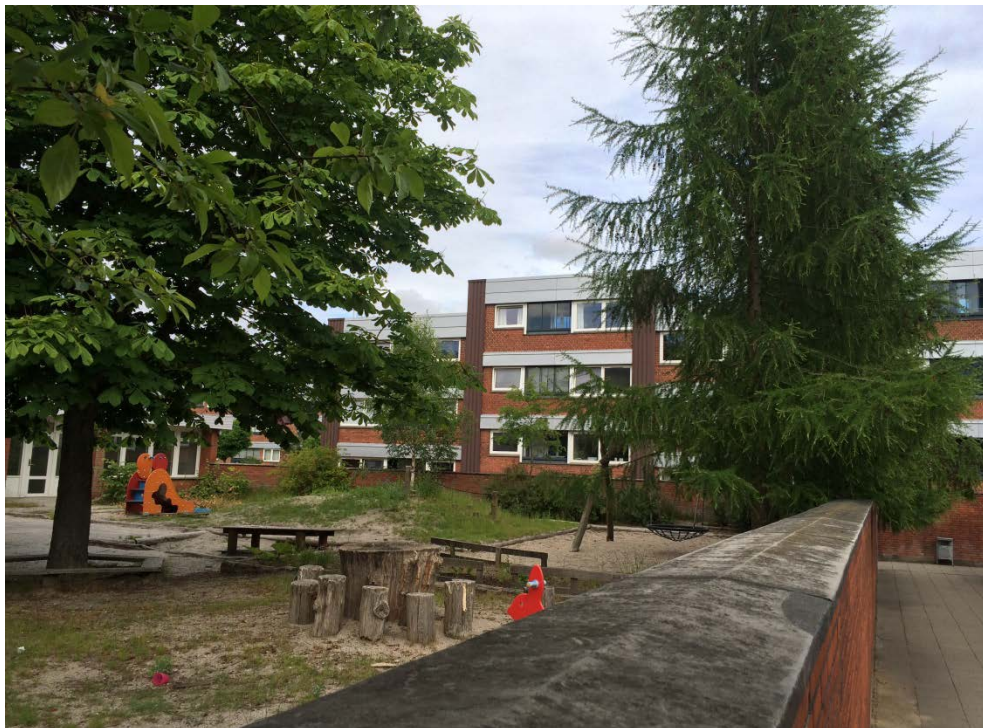
Til bygningen er der et gårdrum, som p.t. er indrettet som legeområde til den tidligere børneinstitution. Det fælles stisystem anes til højre i billedet
