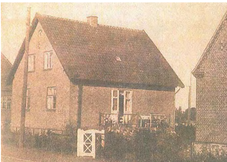
Muremestervilla på Solvangsvej 12 opført af tømrermester Knud Olsen i 1933. Bebygget areal ca. 79 m 2 . Indeholdende to 3-værelses lejligheder. Kælder under hele villaen. Udbudt til 20.000 kr. i 1934.
