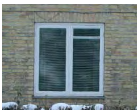
Vindue med lodpost og trækrude
