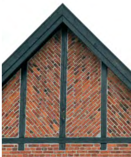
Gavltrekanten på Østervej 20
