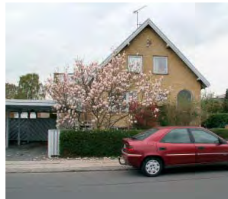
Eksempler på carporte opført som lette konstruktioner i et design, der gør, at carporten arkitektonisk underordner sig hovedbygningen.
