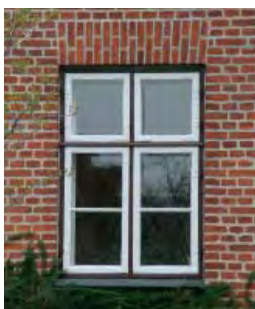
Dannebrogsvindue med lod- og tværpost samt sprosser
