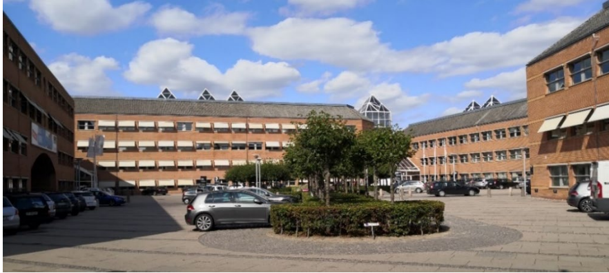
Karrébygningen set fra den sydlige del af gårdrummet mod nord.
