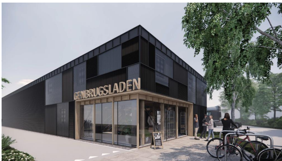
Visualisering af ombygningen af bygningen på hjørnet af genbrugsstationen. Illustration: Sweco Architects.
