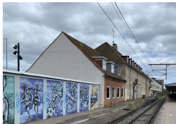
Figur 3. Bygning til pausefaciliteter med grå gavl og rød teglfacade. Set fra perron til S-banen.
