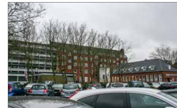
2. Højvangsvejs parkeringsareal med butiksadgang fra bagsiden.
