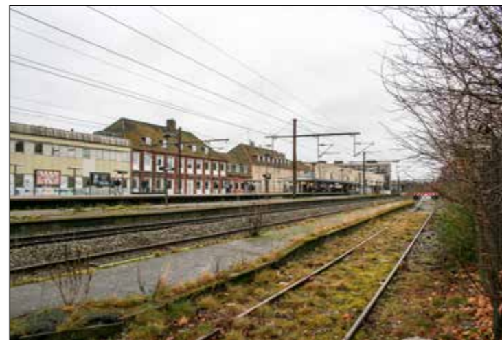
3. Stationsområdet set mod øst. Det er planlagt, at de to bygninger t.v. først for skal rives ned, så snart det er muligt.
