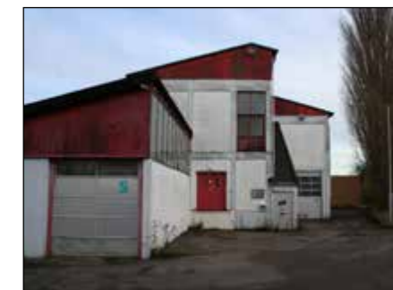
3. Mindre bygning fra 60-70'erne.
