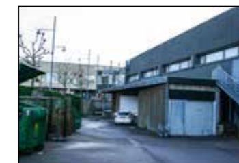
2. Bagside mod Banegårdsvej.
