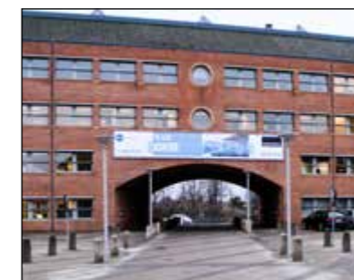
5. Port til gennemkørsel.
