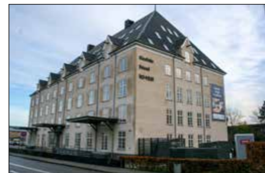
1. Hartmanns pakhus, 1919, med pudset facade og historiske detaljer.
