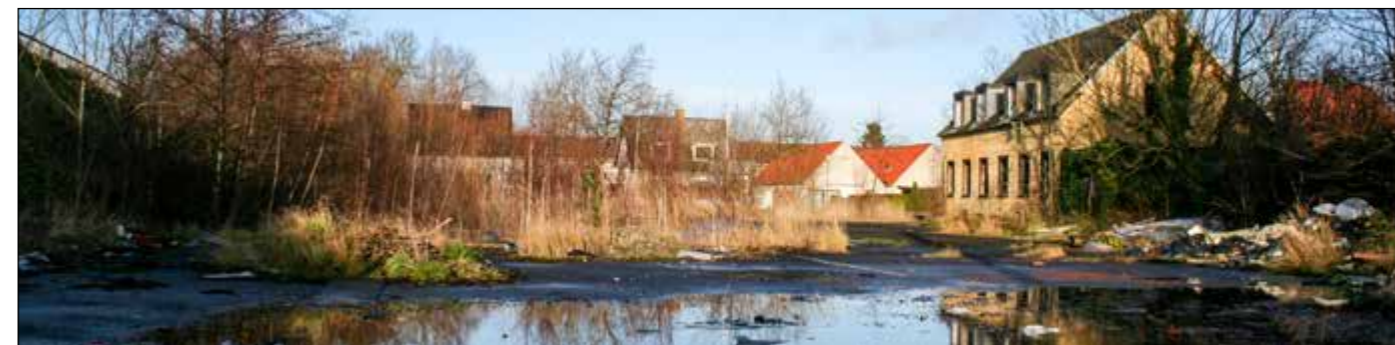
3. Pladsen foran den rømmede bygning er tilgroet og ikke vedligeholdt. Området bliver inddraget i det kommende letbanebyggeri.
