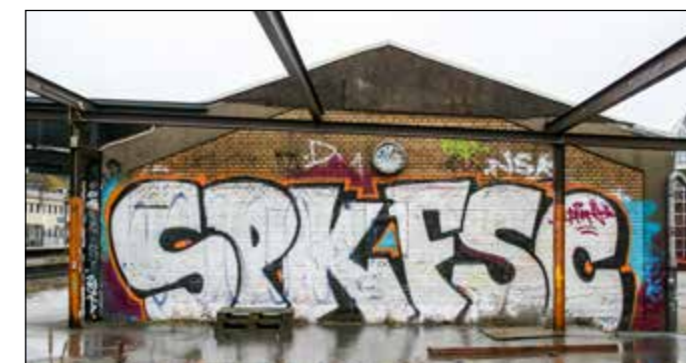
2. Udtjent bygning langs banelegemeerne.
