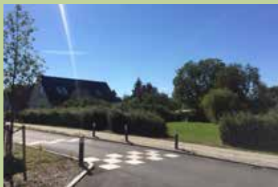
Hastighedsdæmpende bump på Kirkebjerg Allé
