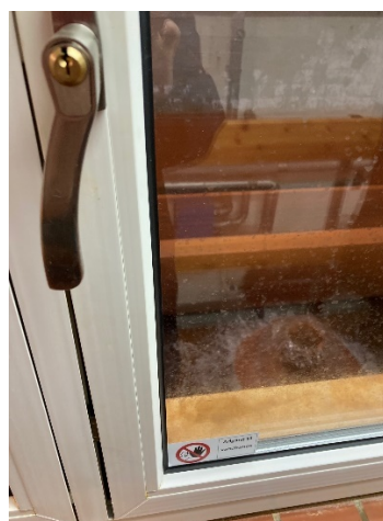
Beluftning over sandfilter. Lås/alarm sikre, at der ikke er direkte adgang til vandbanen.
