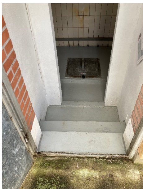
Nedgang til rentvandstank
