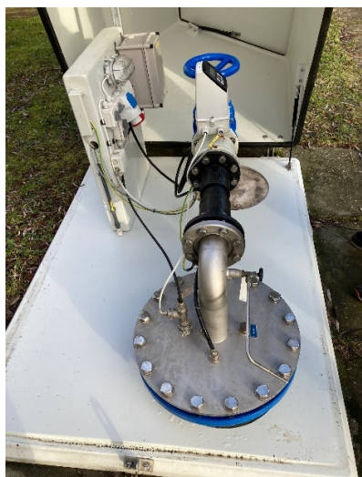
Overbygning helt åben.
