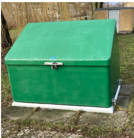
Boring DGU. 200.11110 – HJV2. Overbygning er overjordisk.
