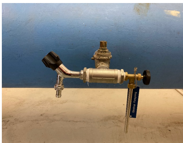
Ny prøvehane (udskiftet efter fund af colibakterie januar 2024)
