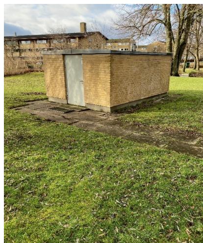
Bygning over rentvandstank
